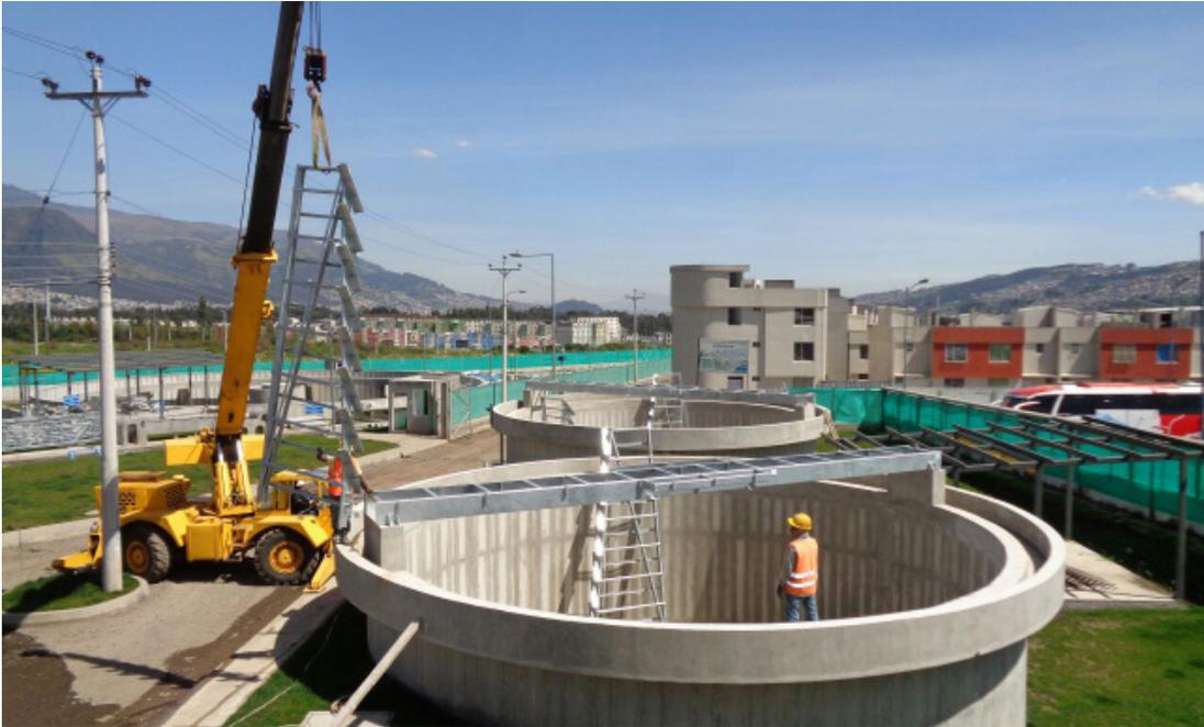
Diseño y fabricación de 2 Espesadores de Lodos para proyecto “ Planta de tratamiento de aguas residuales, Quitumbe” Quito, Ecuador. Cliente: Eseico S.A
