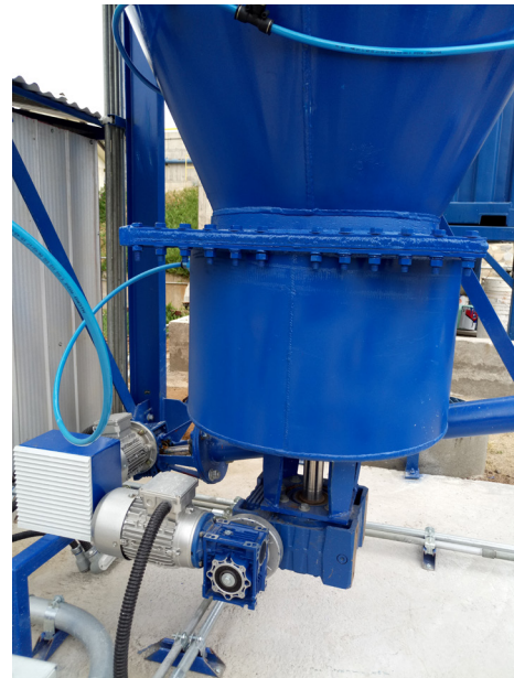
Rompebovedas eficiente que impide la acumulación de cal y permite un correcto funcionamiento del sistema.
