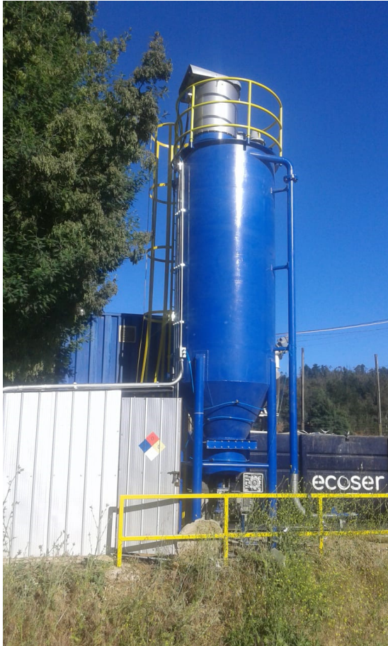
Diseño, fabricación y montaje de Sistema Encalado para Placilla. Cliente: ESVAL S.A.
